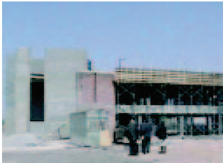
Construcción del primer edificio de la Universidad
